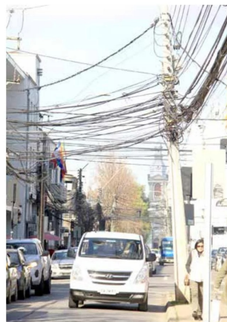
A simple vista se observa el desorden de los cables en pleno centro de Curicó.
