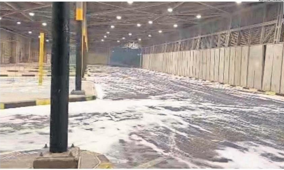
ASÍ LUCE UNO DE LOS ESPACIOS AL INTERIOR DEL COMPLEJO CHUNGARÁ, DONDE SE REVISAN A LOS BUSES Y CAMIONES A 4.680 M.S.N.M.
