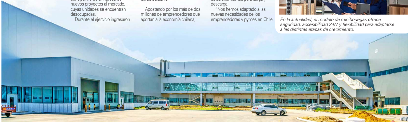
Además de bodegas, en los parques de almacenamiento es posible encontrar espacios de coworking, baños e incluso duchas, comedores y estacionamientos para carga y descarga.
