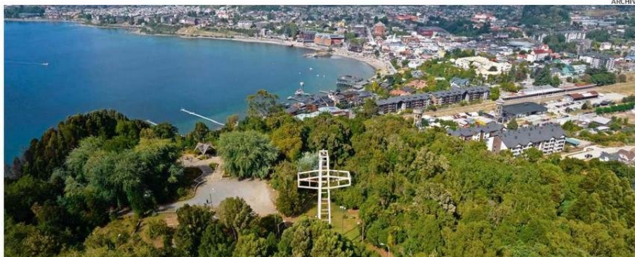
OBRAS DEL PARQUE CERRO PHILIPPI DE PUERTO VARAS ESTARÍAN CONCLUIDAS EN NOVIEMBRE DE ESTE AÑO.
