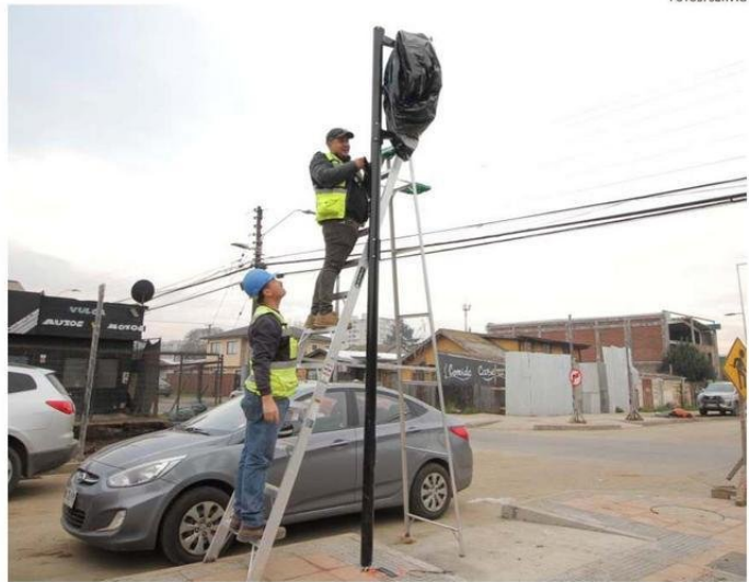
LAS OBRAS DE SEMAFORIZACIÓN SE CONCENTRAN EN LA NUEVA INTERSECCIÓN DE PABLO NERUDA CON AVENIDA CAUPOLICÁN.
