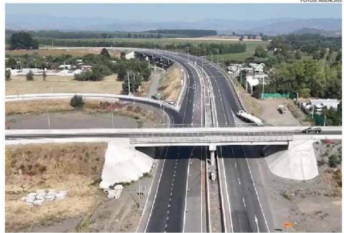
EL PARLAMENTARIO DIJO QUE LAS FALENCIAS QUE HA PRESENTADO LA OBRA HA GENERADO MOLESTIA EN VECINOS DE LA ZONA.
