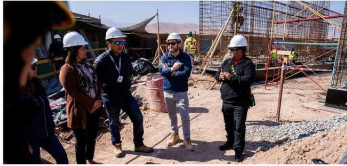
REALIZARON UNA INSPECCIÓN DE LAS OBRAS EN LOS CUARTELES.
