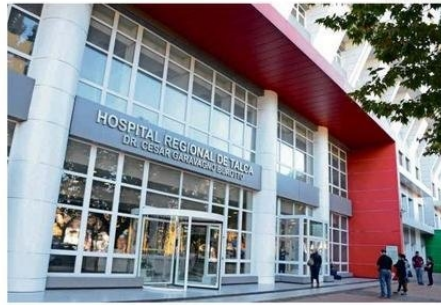
LA CONTRALORÍA DETECTÓ IRREGULARIDADES EN HOSPITAL
