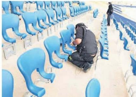
SE REEMPLAZARÁN 5 MIL BUTACAS QUE PRESENTAN DEFECTOS.
