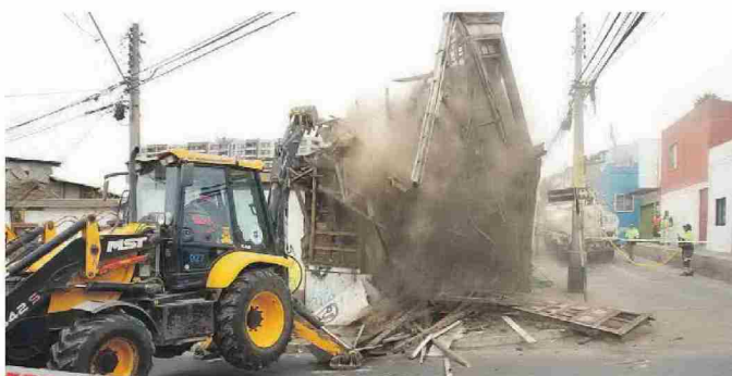
En el mes de abril, el municipio de Coquimbo llevó a cabo la demolición de una edificación emplazada en la esquina de calle Francisco Carmona con Lourdes, en el sector de Villa Dominante que tenía riesgo de derrumbe.
