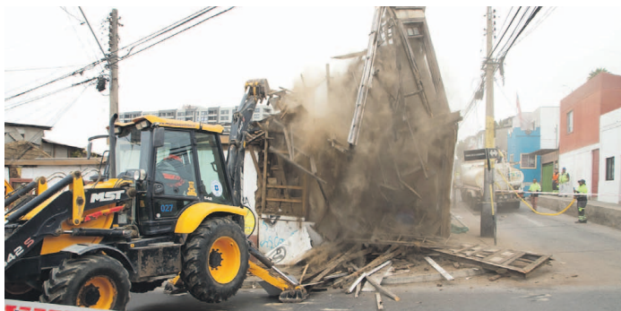
En el mes de abril, el municipio de Coquimbo llevó a cabo la demolición de una edificación emplazada en la esquina de calle Francisco Carmona con Lourdes, en el sector de Villa Dominante que tenía riesgo de derrumbe.
