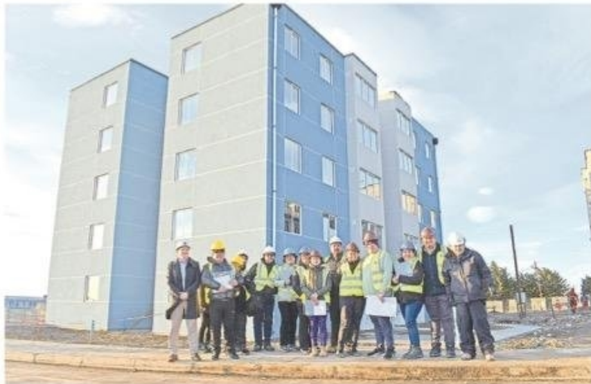
Autoridades y los asignatarios visitaron los departamentos en construcción al final de prolongación Los Flamencos.
