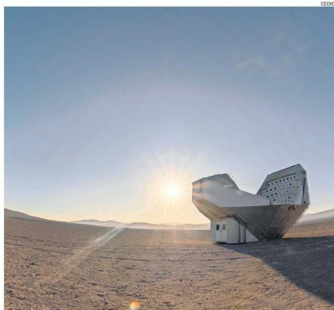
PARTE DEL OBSERVATORIO UBICADO EN ESTACIÓN YUNGAY.
