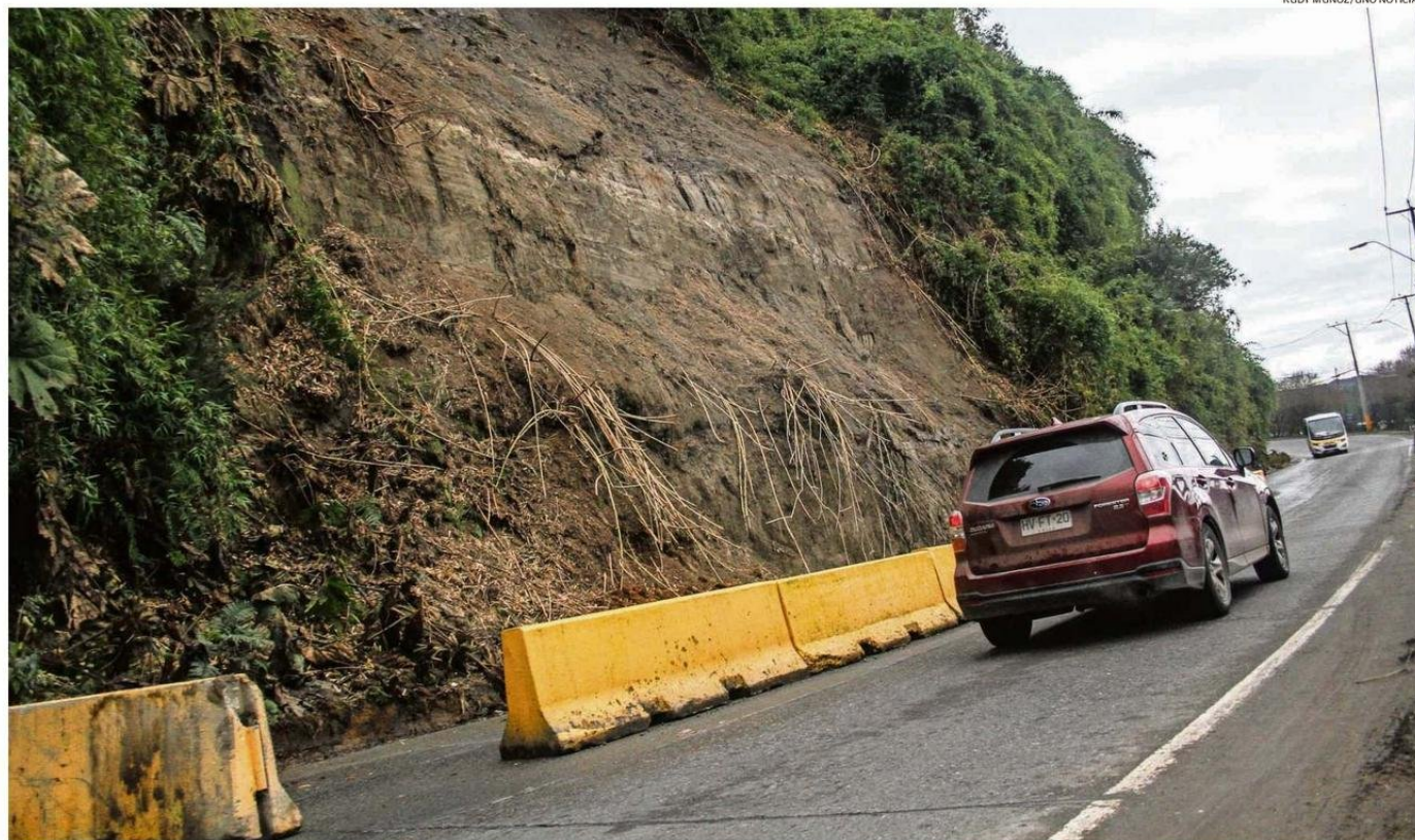
EN EL SECTOR DEL ÚLTIMO DERRUMBE ESTÁ HABILITADA SÓLO UNA VÍA PARA EL TRÁNSITO VEHICULAR.
