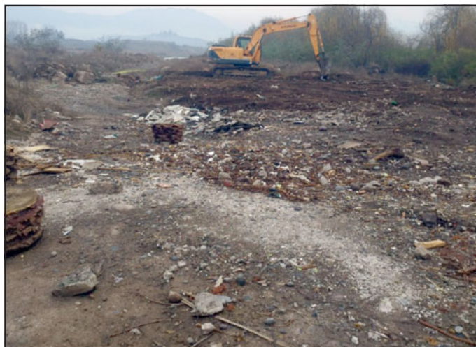
La primera jornada de limpieza consistió en trabajos con maquinarias.
