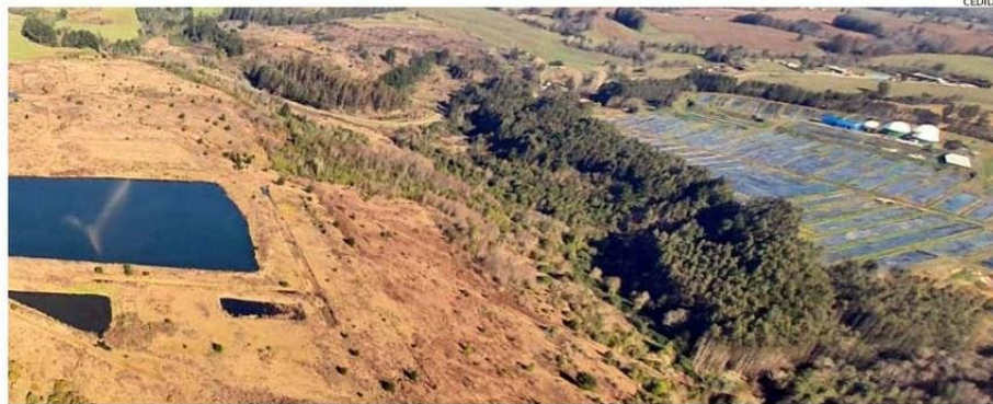
EN LA FOTO SE APRECIA LA PLANTA ECOPRIAL Y LOS HOYOS DEL RELLENO SANITARIO INCONCLUSO, EVIDENCIANDO LA “ZONA DE SACRIFICIO” DEL SECTOR.
