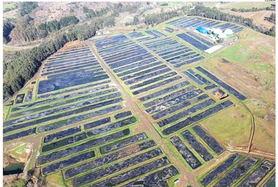
EN LA IMAGEN SE OBSERVAN LAS CELDAS DE TRATAMIENTO DE LA PLANTA ECOPRIAL, QUE ESTÁN COMPUESTAS POR DESECHOS ORGÁNICOS.
