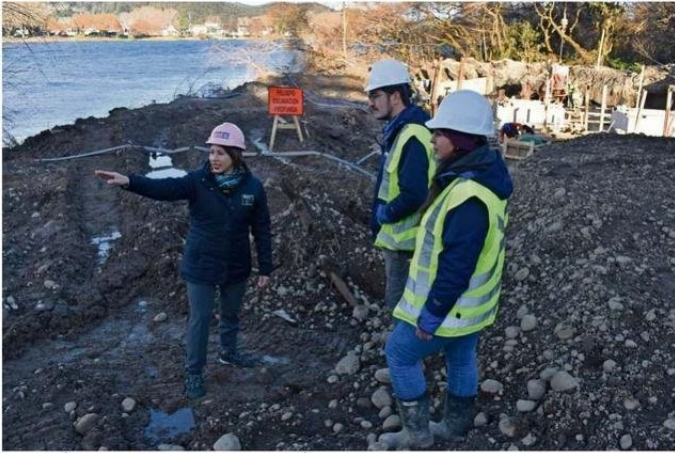
EN LAS PRÓXIMAS SEMANAS COMIENZA LA INSTALACIÓN DE PILOTES PARA SOPORTE DE LA INFRAESTRUCTURA FLUVIAL.
