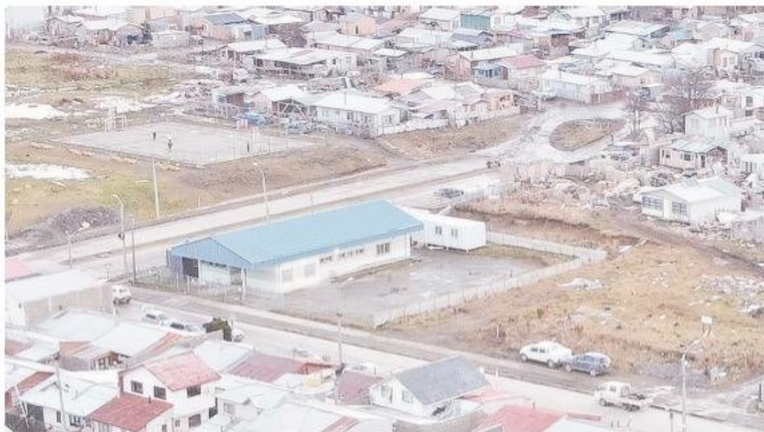
El consultorio Sandra Vargas nació al final de la villa Cardenal Raúl Silva Henríquez, en cuyos alrededores posteriormente se formaron dos campamentos. Razones de índole sanitaria, obligaron a la autoridad a cerrar el recinto de salud, siendo trasladado hasta el edificio donde funcionó el Cesfam Thomas Fenton.
