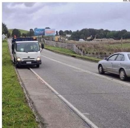
LA RUTA 5 SUR SERÁ INTERVENIDA EN LOS PUNTOS QUE PRESENTAN LOS MAYORES DAÑOS EN DOS TRAMOS EN LA COMUNA DE ANCUD.
