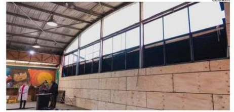
EN EL VICUÑA MACKENNA SE REALIZAN TRABAJOS EN EL PATIO CUBIERTO.
