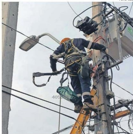
SE REPLAZA EL CABLE DE COBRE DESNUDO POR UNO RECUBIERTO.
