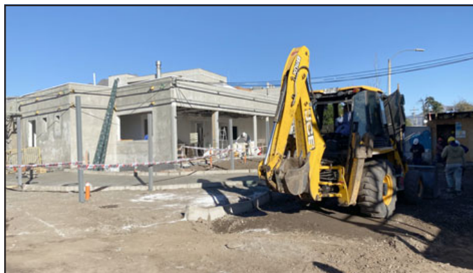
Más de un 60% de avance presentan las obras del SAR.
