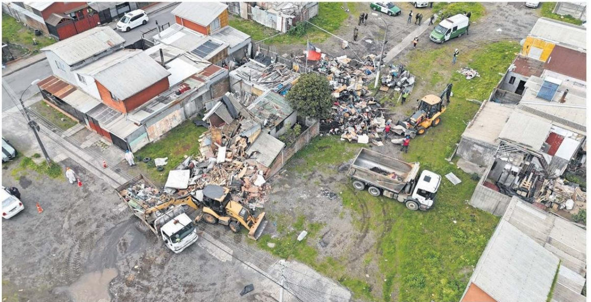
Este lunes se llevó a cabo la demolición de viviendas que ocupaban ilegalmente los terrenos de Enap, los que no contaban con cercado o seguridad.
