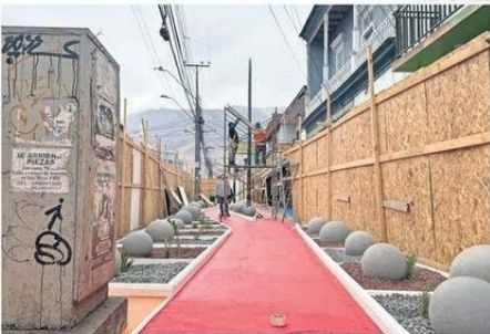
MUNICIPIO CONFIRMÓ ATRASO DE LA EMPRESA CONSTRUCTORA.
