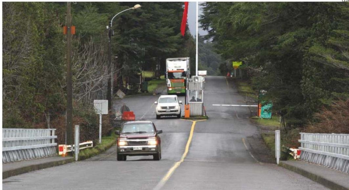
LAS OBRAS DE MEJORAMIENTO CONSIDERAN TRES TRAMOS DISTINTOS DE LA RUTA INTERNACIONAL 215, SIENDO EL ÚLTIMO EL QUE PARTE EN LA GARITA DE ACCESO AL PASO SAMORÉ.
