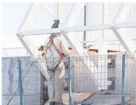
LOS ÚLTIMOS AJUSTES A NUEVO PUENTE ANTES DE SU APERTURA.
