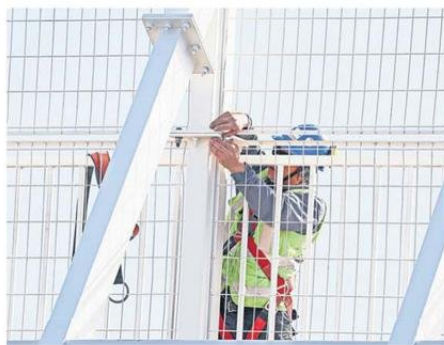
HASTA EL ÚLTIMO DETALLE SE HA REVISADO DE LA ESTRUCTURA.
