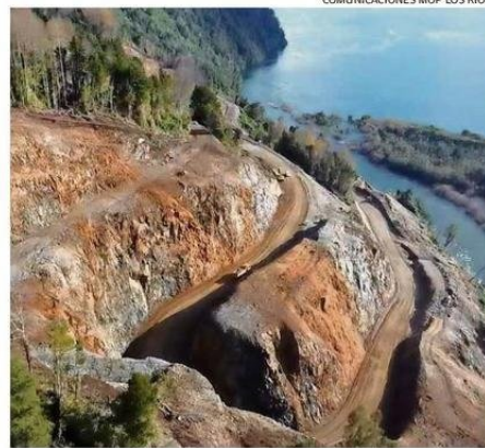
LA OBRA FUE FINANCIADA Y EJECUTADA POR LA DIRECCIÓN DE VIALIDAD.
