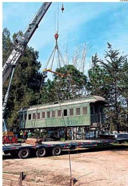
PARA INSTALAR LOS CARROS SE USÓ GRÚA DE GRANDES DIMENSIONES.
