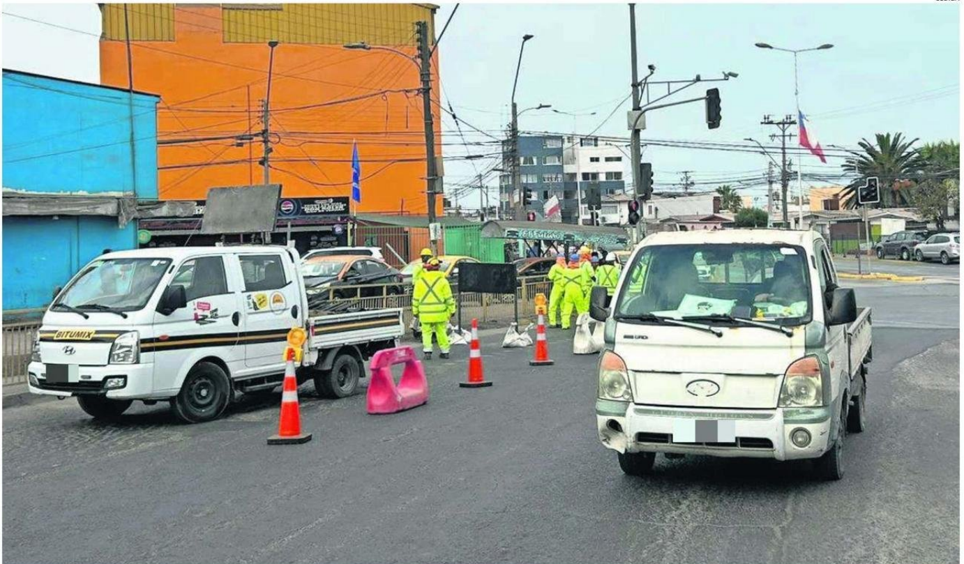
EN SU PRIMER DÍA, LA EMPRESA A CARGO DE LOS TRABAJOS COMENZÓ A DELIMITAR LAS ZONAS QUE SERÁN INTERVENIDAS.
