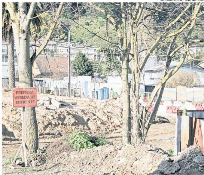
LOS TRABAJOS A UN COSTADO DEL PUENTE YA SE ESTÁN REALIZANDO. LAS EXPECTATIVAS SON ALTAS.
