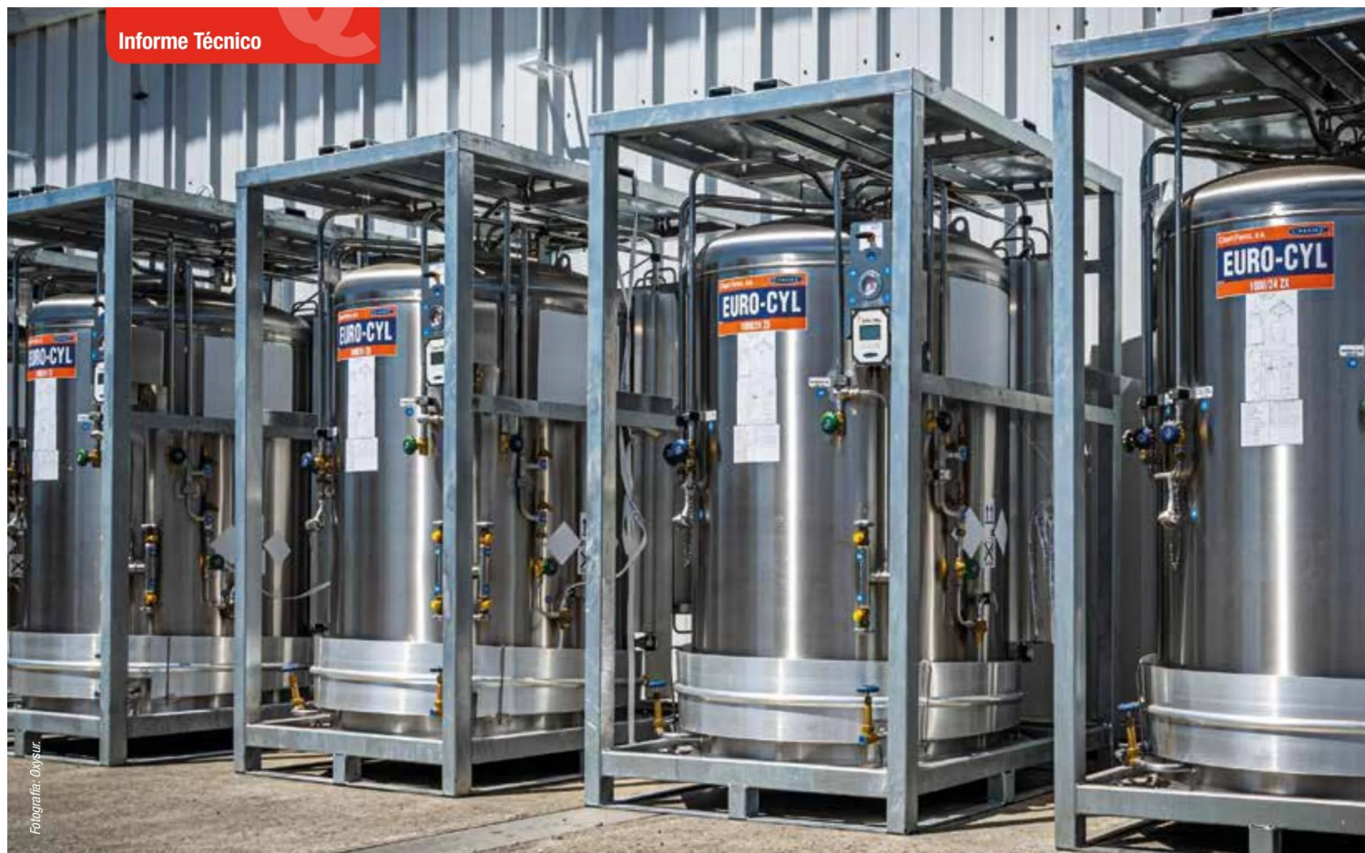
Estanque de Oxígeno líquido (LOX) de OxySur.
