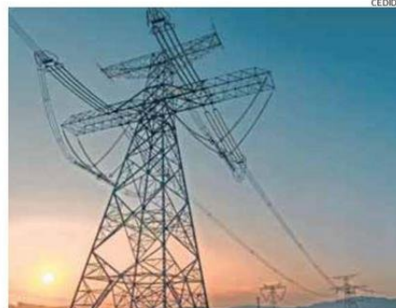
EL PROYECTO HVDC CONSIDERA LA INSTALACIÓN DE 2.692 TORRES.
