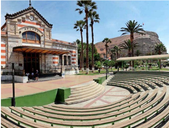
Edificio de la antigua aduana en la ciudad de Arica.
