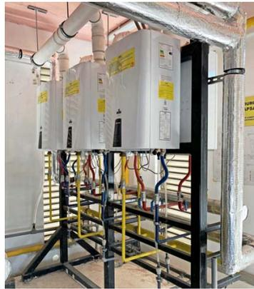
Calderas de condensación en cascadas y calefón de condensación en cascada.
