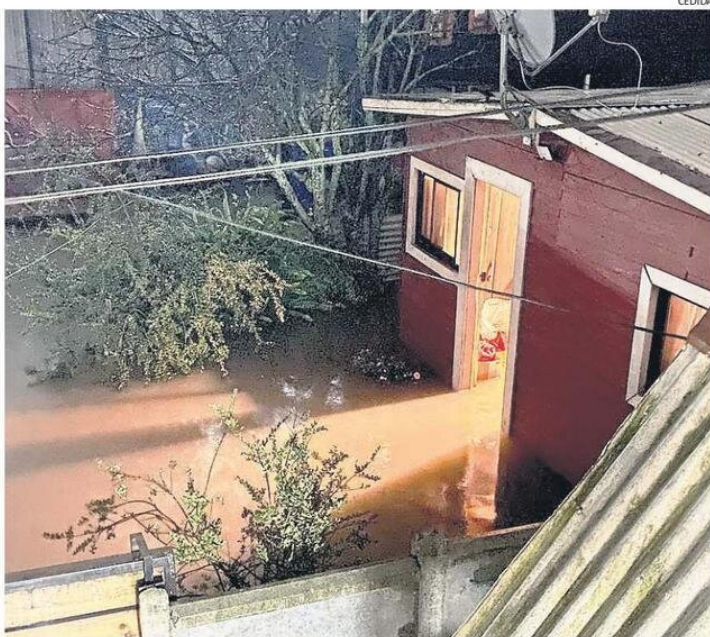
ASI QUEDÓ UNA DE LAS VIVIENDAS EN ANGOL BAJO DURANTE LAS LLUVIAS DEL PASADO MES DE JUNIO.
