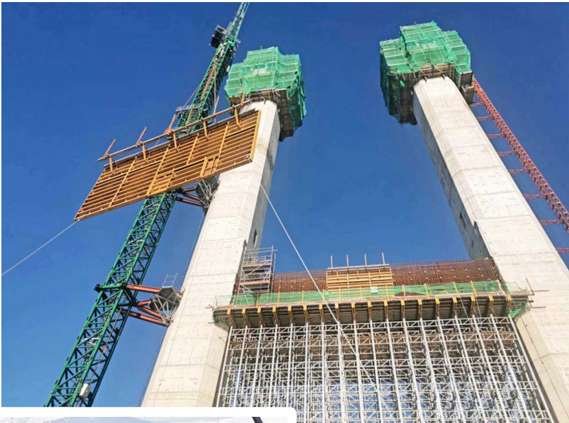
Viaducto Sargento Menadier (Santiago), cuya infraestructura fue resuelta con los sistemas Round Column y Plate Girder autoportante.
