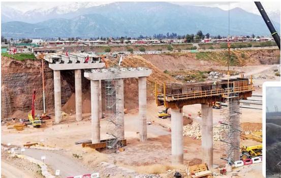
Viaducto Sargento Menadier (Santiago), cuya infraestructura fue resuelta con los sistemas Round Column y Plate Girder autoportante.
