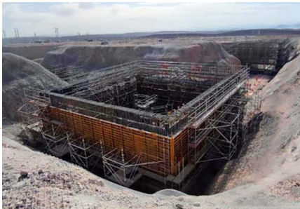
Espesadores de relave, muros de gran altura encofrados con paneles Plate Girder, en la minera Nueva Centinela (Calama).
