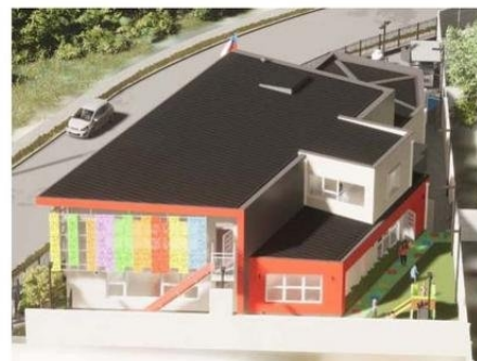
EL PLAZO DE EJECUCIÓN DE LA OBRA ES DE UN AÑO Y LA CONSTRUCTORA A CARGO ES JUAN PIZARRO YÉVENES.
