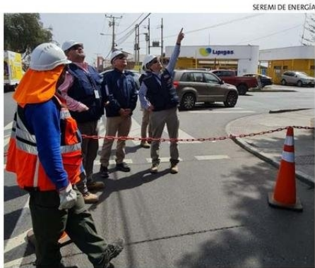
AUTORIDADES SUPERVISARON TRABAJOS DE CGE EN TERRENO.
