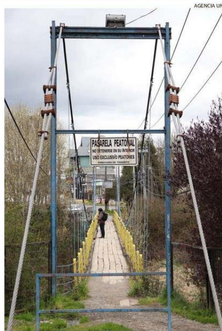
EN EL SECTOR DONDE ACTUALMENTE SE EMPLAZA UNA PASARELA PEATONAL SERÁ CONSTRUIDO UN NUEVO PUENTE PARA LA CIUDAD.
