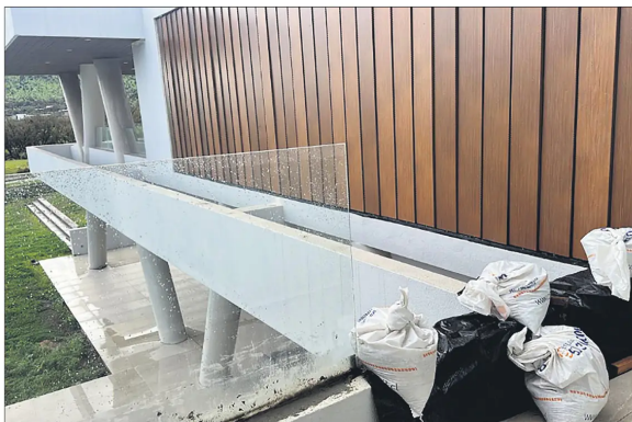
Así luce una de las barandas en remodelación.
