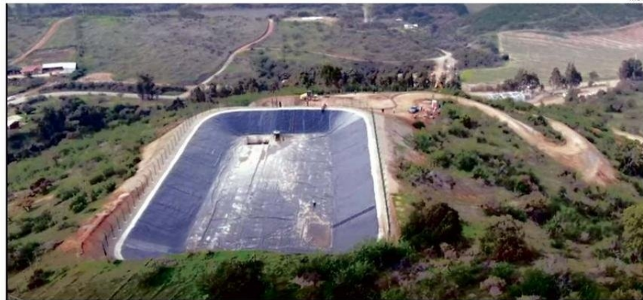
EL SISTEMA AVANZA EN SU CONSTRUCCIÓN.
