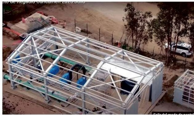
EL MOP ESTÁ EN LA TERCERA ETAPA DE CONSTRUCCIÓN.
