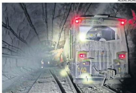
SE DETUVO REMOCIÓN DE ESCOMBROS EN EL PROYECTO ANDESITA.
