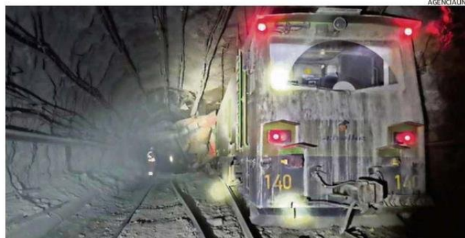
SE DETUVO LA REMOCIÓN DE ESCOMBROS EN EL PROYECTO ANDESITA.
