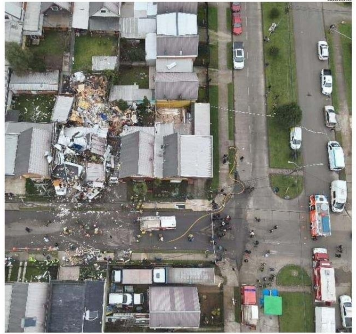
LA RECIENTE EXPLOSIÓN DE CASA EN FUNDO EL CARMEN LLAMA A REFORZAR LA SEGURIDAD DOMÉSTICA.
