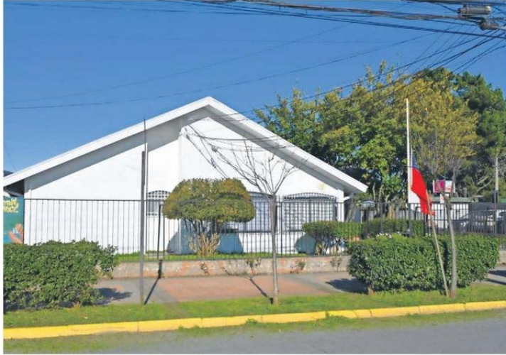
El comienzo de las obras se estima para las próximas semanas.
