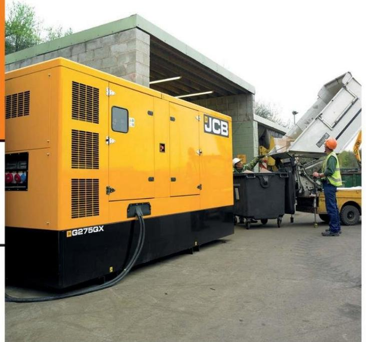
exigentes. Su estructura en acero sin componentes plásticos y su acabado con pintura en polvo de alta resistencia garantizan una excelente protección contra la corrosión y los rayos UV. La cabina insonorizada, con niveles de ruido que van desde los 63 a 76 dB(A), minimiza la contaminación acústica sin afectar la potencia del equipo, lo que los hace adecuados incluso para entornos urbanos o comerciales.
