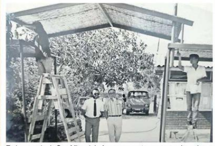
En la escuela de San Miguel de Azapa se contruyeron sombreaderos, hubo arreglos de duchas y cambio de radiador. (02/01/1992).
