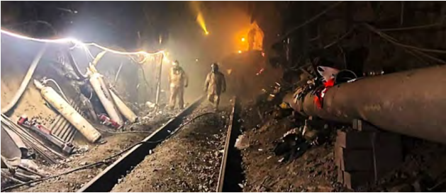
El organismo permitió operar sectores no alcanzados por el accidente del 31 de julio, tras verificar en terreno condiciones de seguridad y revisar el informe técnico de Sernageomin. La medida rige para Pilar Norte, Panel Esmeralda, Esmeralda, Pacífico Superior, Diabolo Regimiento, Panel Reno, Dacita y Reservas Norte. Continúa la suspensión en Recursos Norte, Andesita, Andes Norte y Diamante, mientras avanzan las investigaciones.
