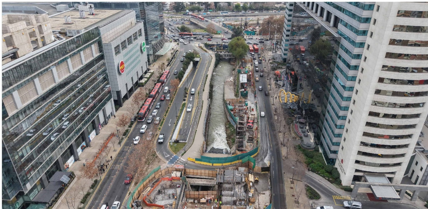
► Los trabajos simultáneos se están desarrollando en cuatro frentes: Canal San Carlos, Parque Metropolitano, Santa Clara y en el denominado Punto de Quiebre.
