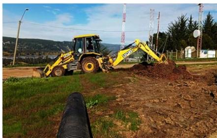
abierto zanjas con retroexcavadora para la colocación de los drenajes. Ade-
